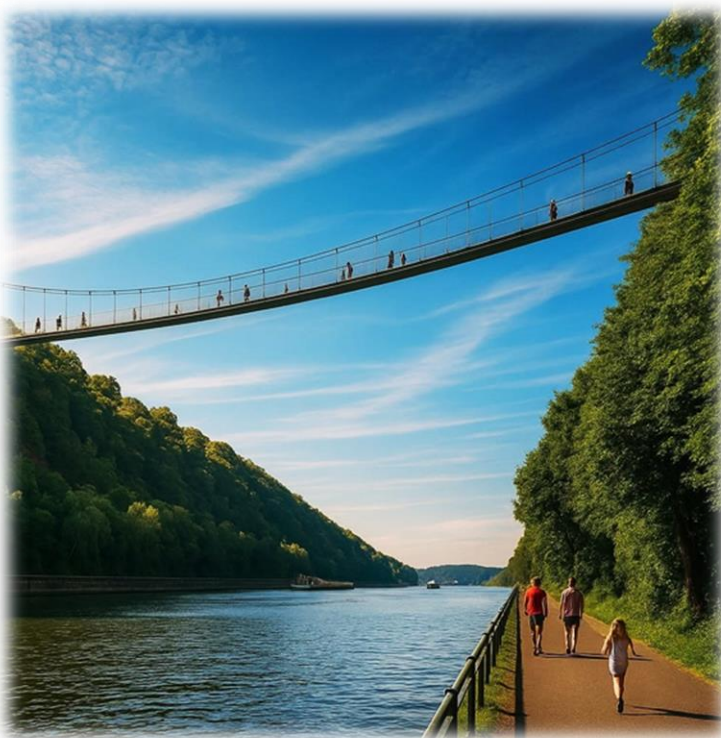
Passerelle de Caster ( Bassenge-Visé) : pont suspendu de 195 m de long et 50 m de haut qui rétablit un lien historique entre Maastricht et Liège.
